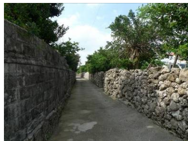
真壁集落内に残された石積み
