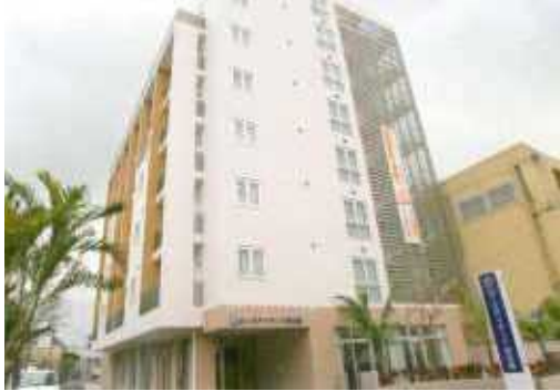
通り会側の壁面は低層階とそれ以外を分節し、さらに階段室をルーバーで囲うことで、壁面に変化をもたせている。
