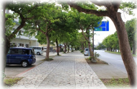
琉球石灰岩を使用した事例
