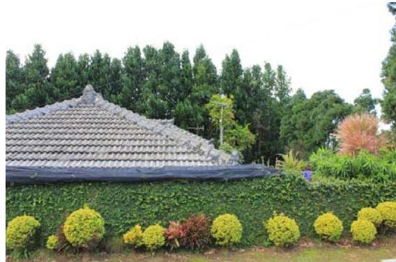
セメント瓦屋根の住宅(今帰仁村)
