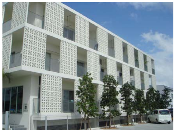
花ブロックを活用した集合住宅(那覇市)
