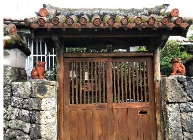
赤瓦屋根と木造の屋門（ヤージョー）（那覇市・首里金城町）
