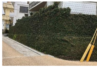
オオイタビ等によるブロック塀の壁面緑化（那覇市・当蔵）
