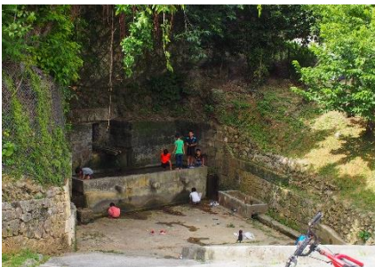
復元された石積みのヒージャーは子どもたちの水遊び場ともなっている（浦添市仲間樋川）
