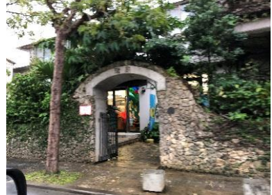
琉球石灰岩張りのブロック塀とアーチ門（那覇市・崎山町）
