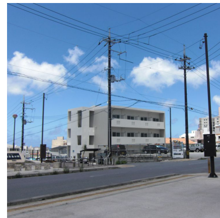
明度の低い茶色（Y R系）で塗装された電柱が立ち並ぶ景観〔那覇新都心〕
