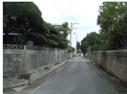
【真謝集落内のブロック塀が好ましくない】
