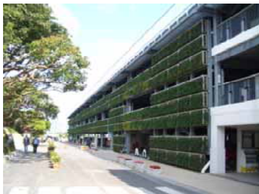
壁面緑化している立体駐車場
