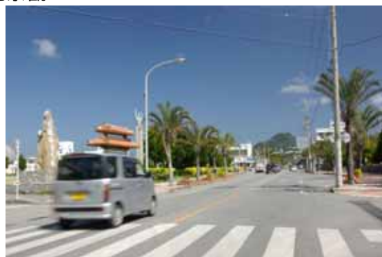
国道 449 号本部循環線沿線(大浜)
