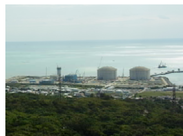
吉の浦火力発電所
