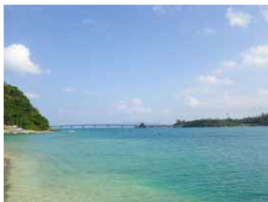
運天港より古宇利大橋を望む
