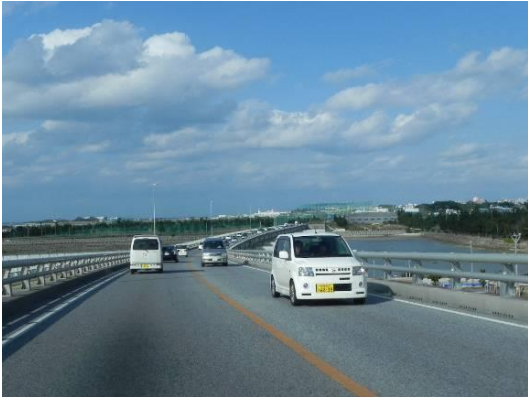
【沖縄西海岸道路 豊見城道路・糸満道路】瀬長から豊崎へつながる高架道路で、西側には海を眺めることができ、東側にはまちなみや緑を眺められます。
