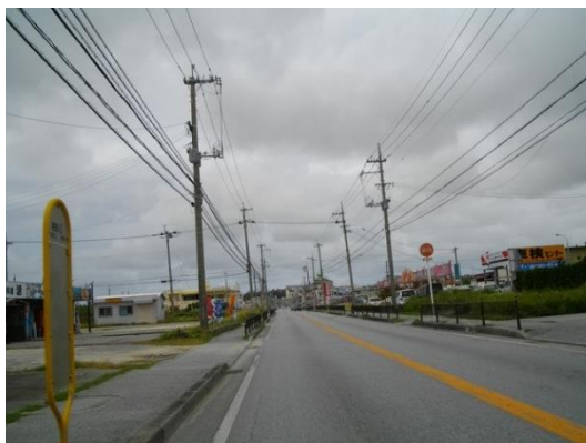
【国道331号】直線道路が続く特徴的な景観。伊良波周辺は低い建物が多く、空の広がりを感じられます。
