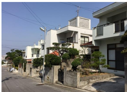
市内に見られる多くの団地開発には、意匠が統一されており、景観に配慮した開発が多い。しかし、造成された大きな擁壁が周囲の景観に影響を与えています。今後の建て替えを踏まえた対応が必要です。(写真:根差部)
