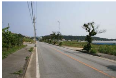
【国道 507 号 具志頭地域】
