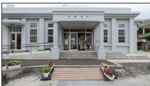
復元された与那原駅舎 (現与那原町立軽便与那原駅舎展示資料館)
