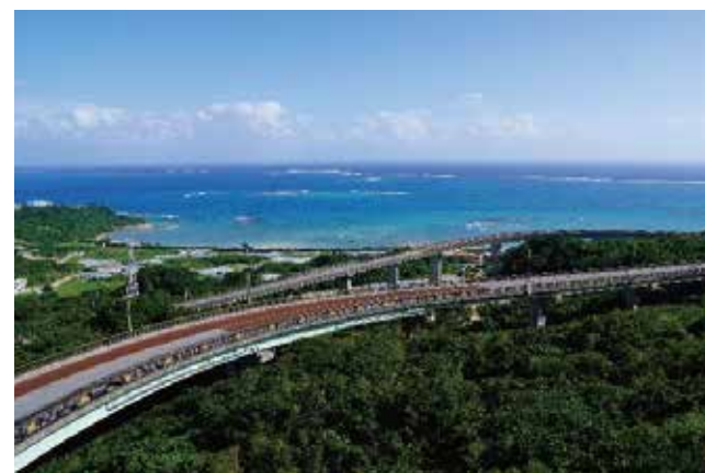
ニライ橋・カナイ橋
