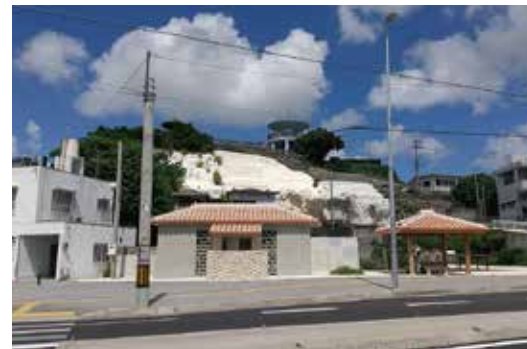
令和3年度山巔毛公園整備(便所・東屋)
