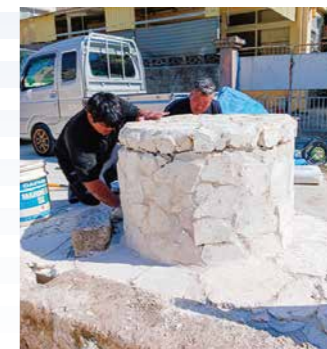
目地入れ作業
